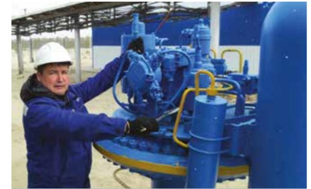
Рис. 3. Техническое диагностирование шарового крана ЧКД Бланско Ду 1000 мм, компания «Газпром трансгаз Сургут»
