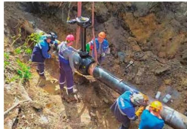
Рис. 6. Замена газовых колодцев на современные шаровые краны
