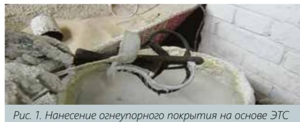
Рис. 1. Нанесение огнеупорного покрытия на основе ЭТС
