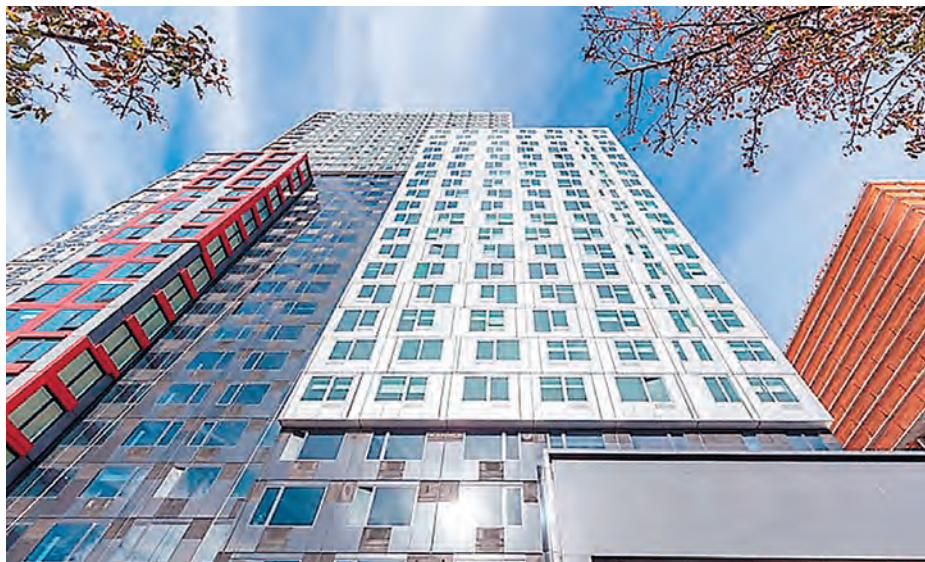
Основу нью-йоркского небоскреба 461Dean составляют 930 жилых модулей, изготовленных на Бруклинской военно-морской верфи
